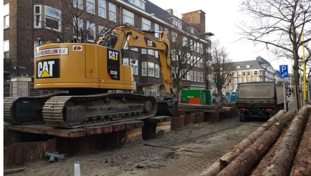
Werkzaamheden aan het riool in de Maasstraat, Amsterdam (foto: Melika Levelt)
