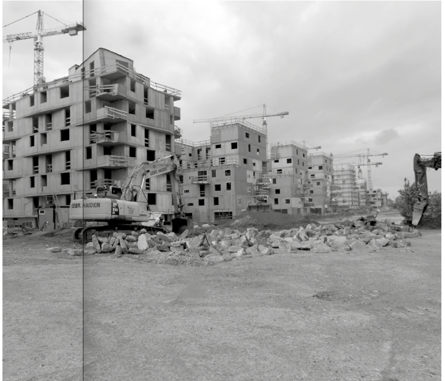
De bouw van Seestadt Aspern in Wenen (bron: CIVIC-project)
