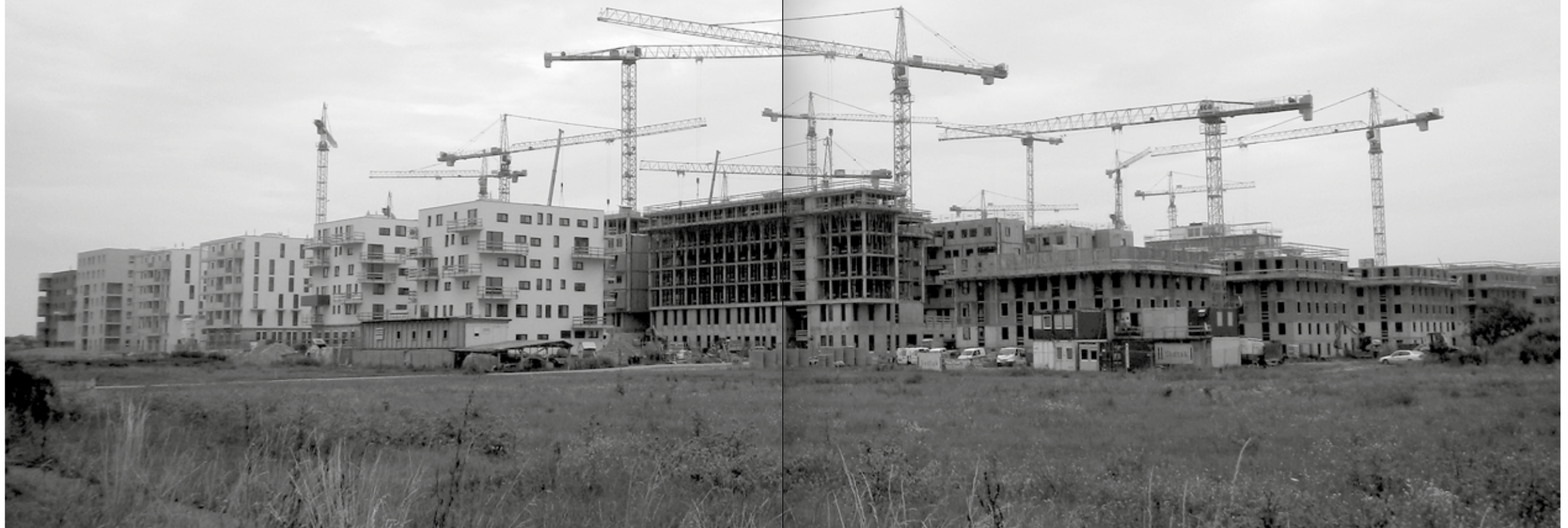
De bouw van Seestadt Aspern in Wenen (bron: CIVIC-project)
